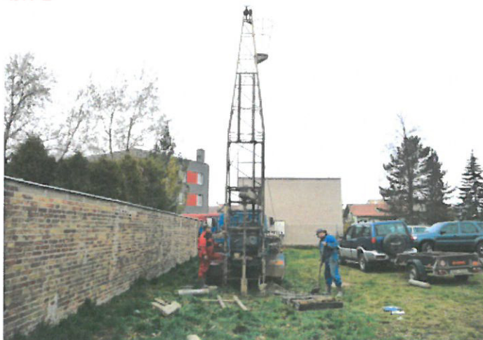
IJH-2 - v průběhu hloubení vrtu; pohled od východu
